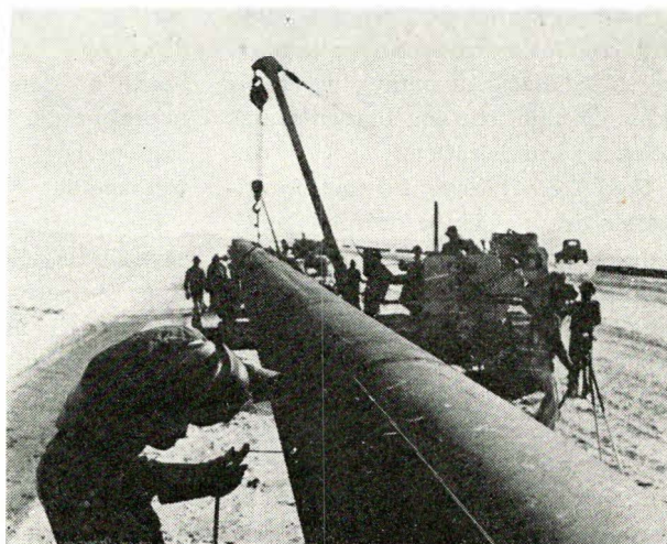
Hverken ørkenhede eller sandstorme kunne stoppe de hårdføre arbejdere, som svejsede den Trans-Arabiske olieledning sammen til verdens længste rør.
